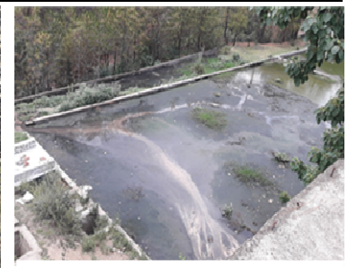
शामती, सोलन सीवेज प्रशोधन संयंत्र में जल से पटा हुआ/ बहते हुए जल में अनावृत मल सुखाने वाले संस्तर (05 जून 2018)
